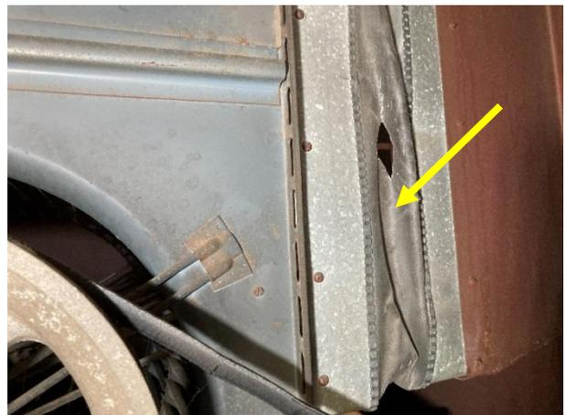
Bild 22: HP22, Kompensator textil
