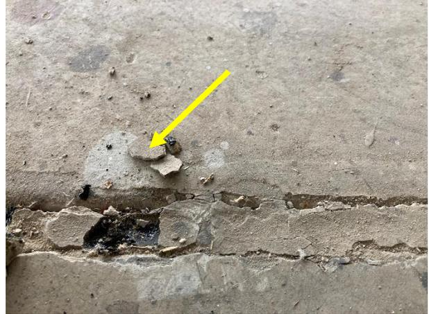
Bild 14: HP14, Fugenmasse, grau, mineralisch
