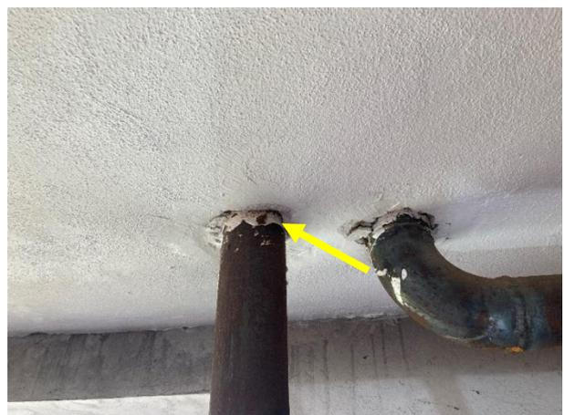
Bild 24: HP24, Spachtelmasse Deckendurchgang Heizrohr
