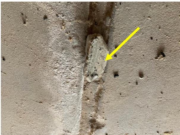
Bild 15: HP15, Fugenmasse, grau, mineralisch
