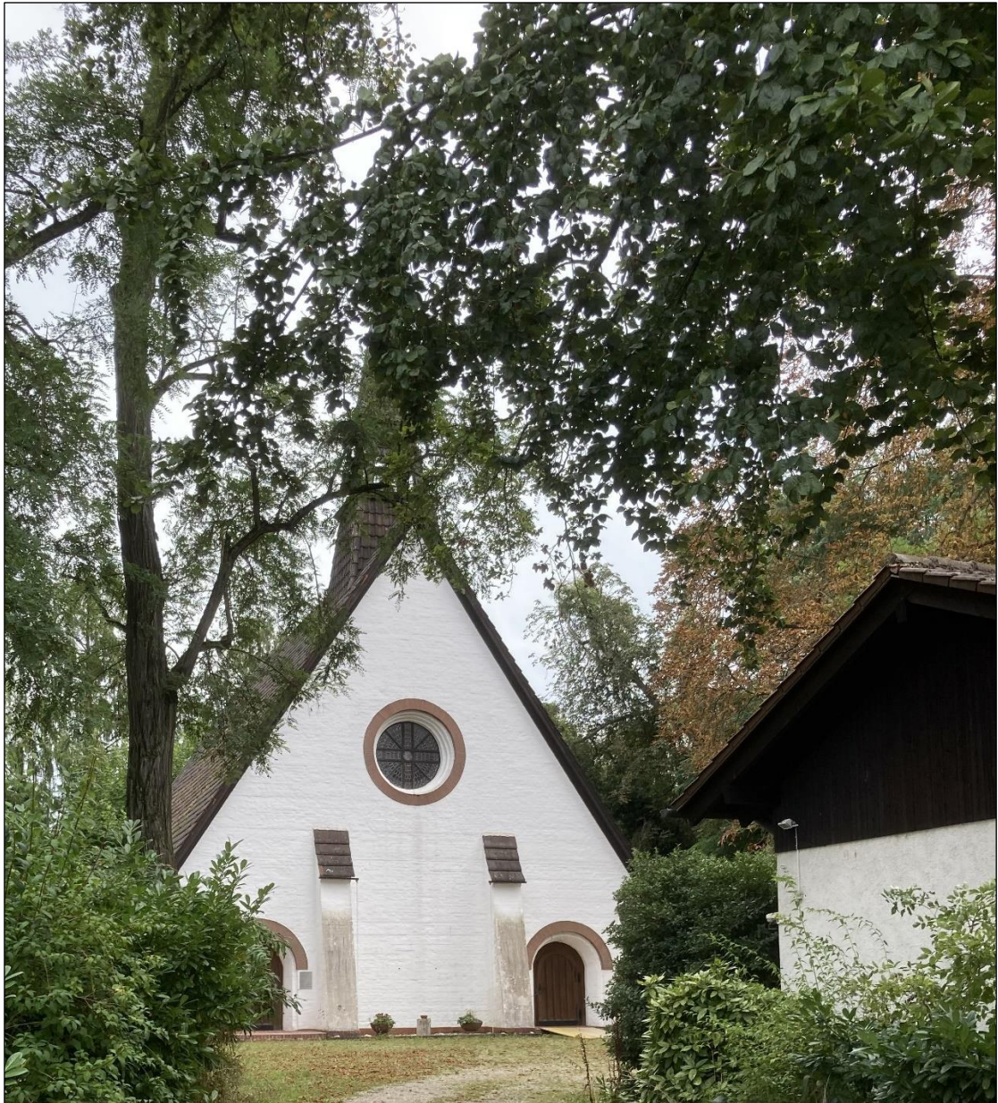
Ludowici-Kapelle (links) und Gemeindehaus (vorne rechts), Quelle: Eigene Aufnahme, 17.09.24
