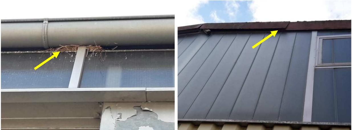
**Abbildung 4:** Links: Nistmaterial unter der Dachrinne der zentralen Halle; Rechts: Spalten am Dachüberstand auf der Nordseite der südlichen Halle.
