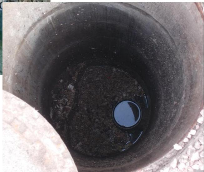
Bild 006: geöffneter Leichtflüssigkeitsabscheider
