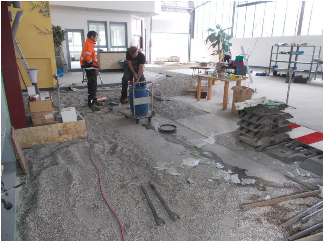
Bild 001: Rammkernbohrung zur Erkundung der verfüllten Wartungsgrube im Westteil der Lagerhalle 1
